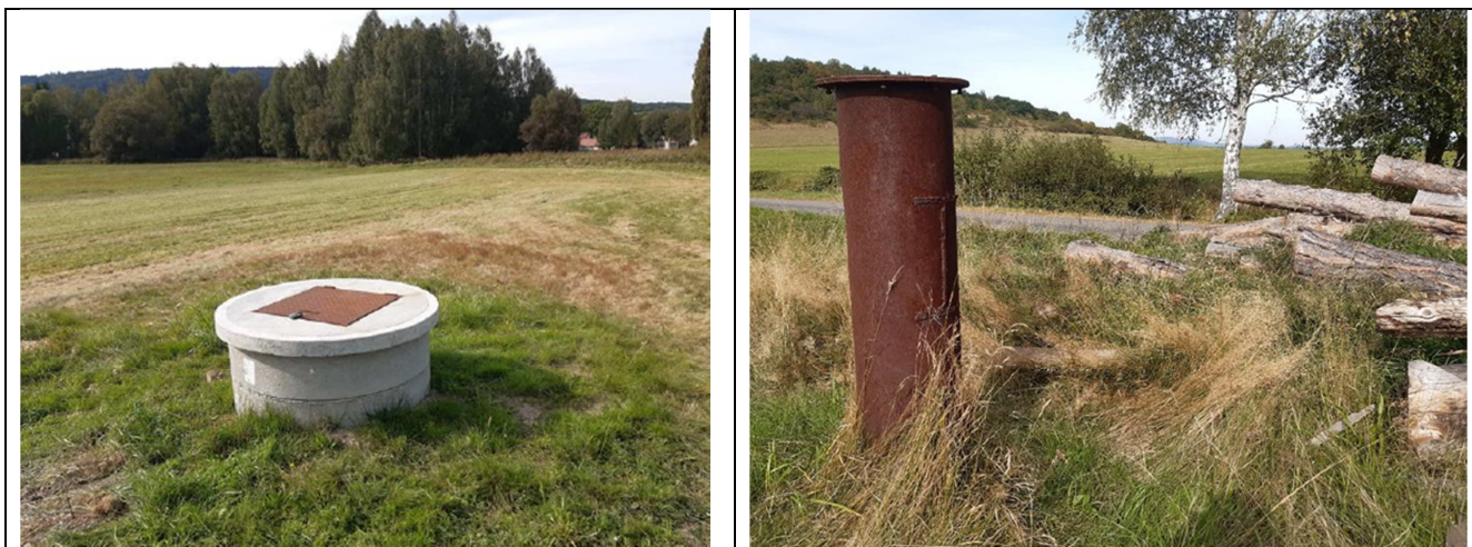
Obr. č. 21 Stávající vrtů S-4 a S-5 v majetku obce
